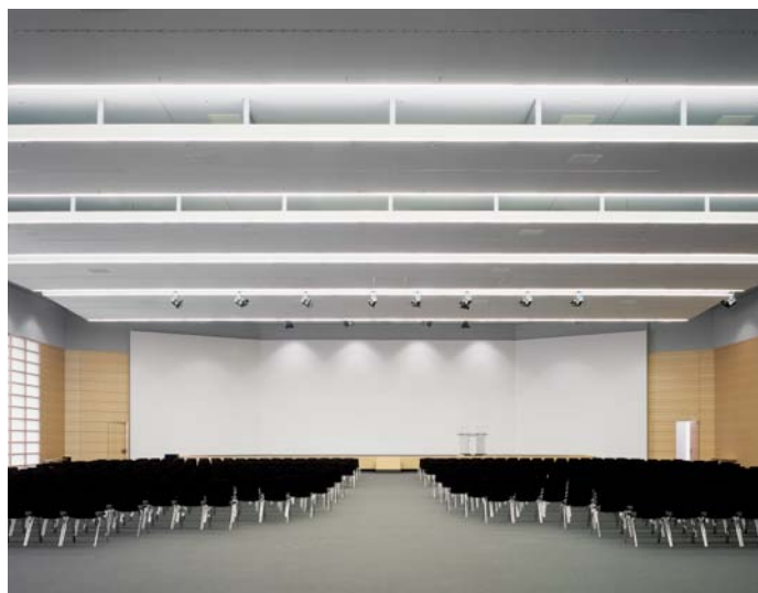
Dans la salle de conférence Tokio, huit pans de faux plafond d'inclinaison différente intégrés permettent une réflexion optimale.
