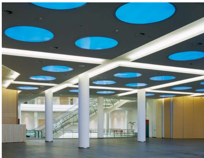
Dans le plan de calepinage suspendu de la salle polyvalente Sydney, des éclairages et des vitres de plexiglas ont été encastrés.
