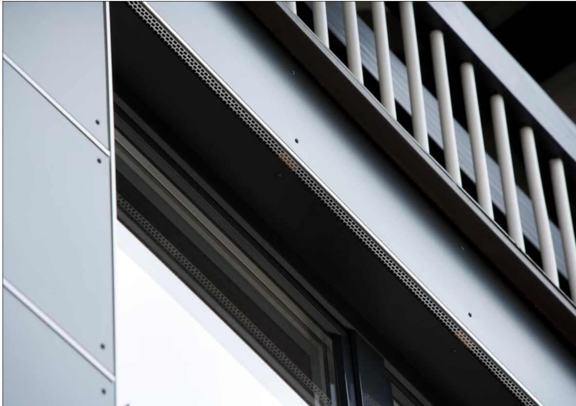
Im Sturzbereich: Lüftungswinkel Nr. 9071 Alu natur und Sockel- / Tropfkantenprofil Nr. 9083 Alu natur.
