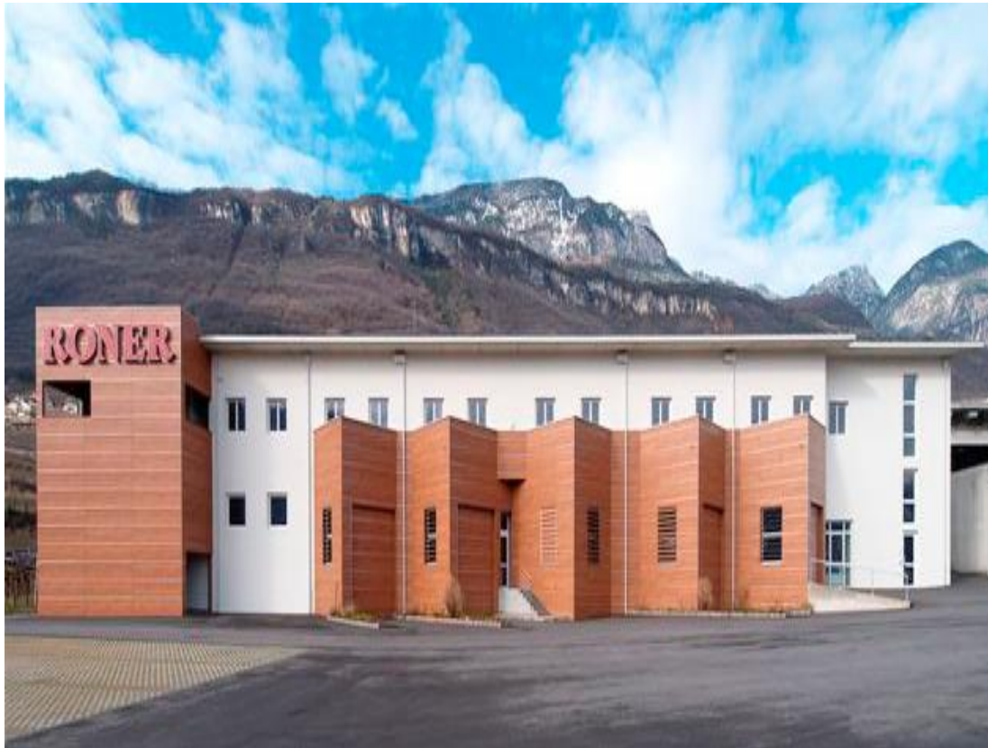
Schöne Kombination von Putzfläche und vorgehängter Fassade.
