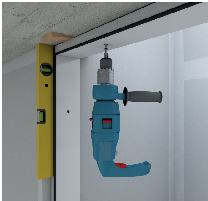
Rahmen fixieren und verschrauben
