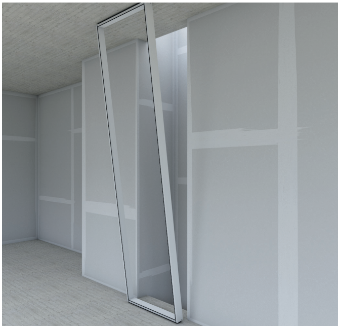
Einbau des Rahmens
