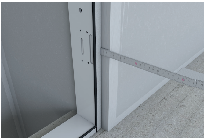
Einmessen und ausrichten
