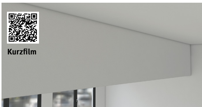
Vorder- und Rückseite ausglätten / verputzen und Farbbeschichtung applizieren, PE Dichtungsband abschneiden
