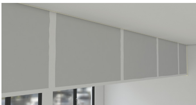
Plattenfugen, Schraubenköpfe und Randanschlüsse verspachteln
