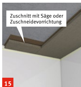
15. Zweite Plattenreihe mit halber Platte beginnen
