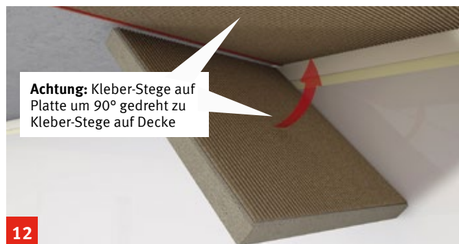
12. Platte an Linie ansetzen , Klebetechnik im Floating Buttering – Verfahren
