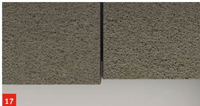
17. Überstehenden Kanten und Unebenheiten mit Schleifbrett abschleifen und egalisieren
