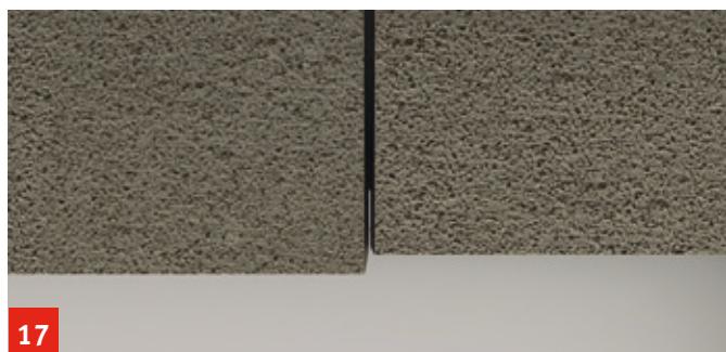
17. Poncer et égaliser les bords saillants et les irrégularités avec une planche à poncer
