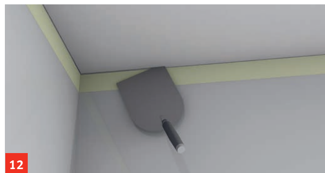
6. Eseguire un taglio svedese per evitare la formazione incontrollata di crepe
