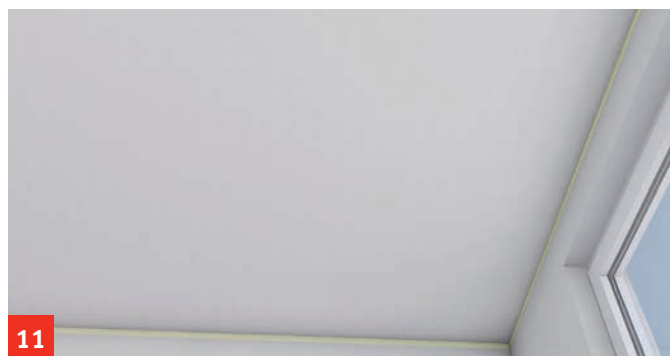
11. Lisciare con il lato liscio della spatola dentata, rifinire con una spatola liscia grande
