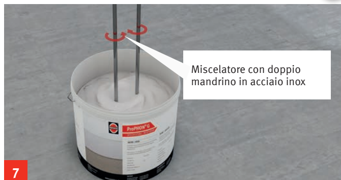
7. Miscelare l'intonaco acustico ProPHON F, attenendosi rigorosamente alle indicazioni del produttore.
