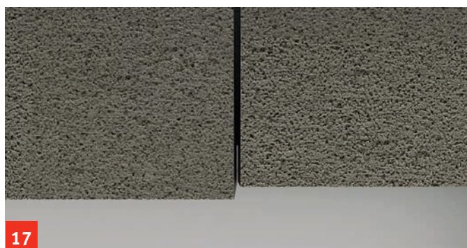
17. Levigare e livellare i bordi sporgenti e le irregolarità con una levigatrice
