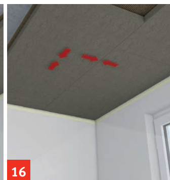
12. Posizionare il pannello sulla linea, incollare con la tecnica del floating buttering
