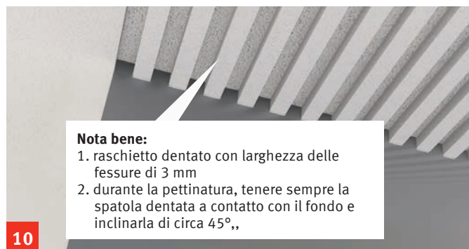
10. La quantità di materiale da applicare si ottiene grazie alla corretta altezza della spatola.
