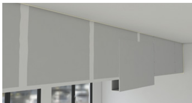
Äussere Lage mit U-förmigen Formteil beplanken. Fugen fachgerecht verspachteln
