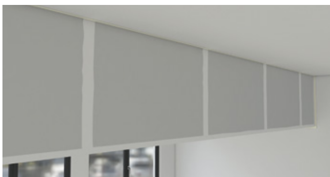
Plattenfugen, Schraubenköpfe und Randanschlüsse verspachteln
